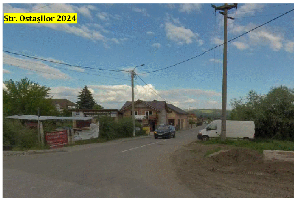
Figura 4.16. Amenajare Str. Ostașilor – 2024. Sursa: Google Maps, 2025.
